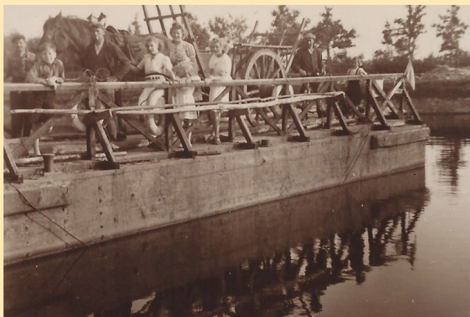
Houten noodbrug in Lommel-Barrier in 1940. (verzameling IWM, London)
